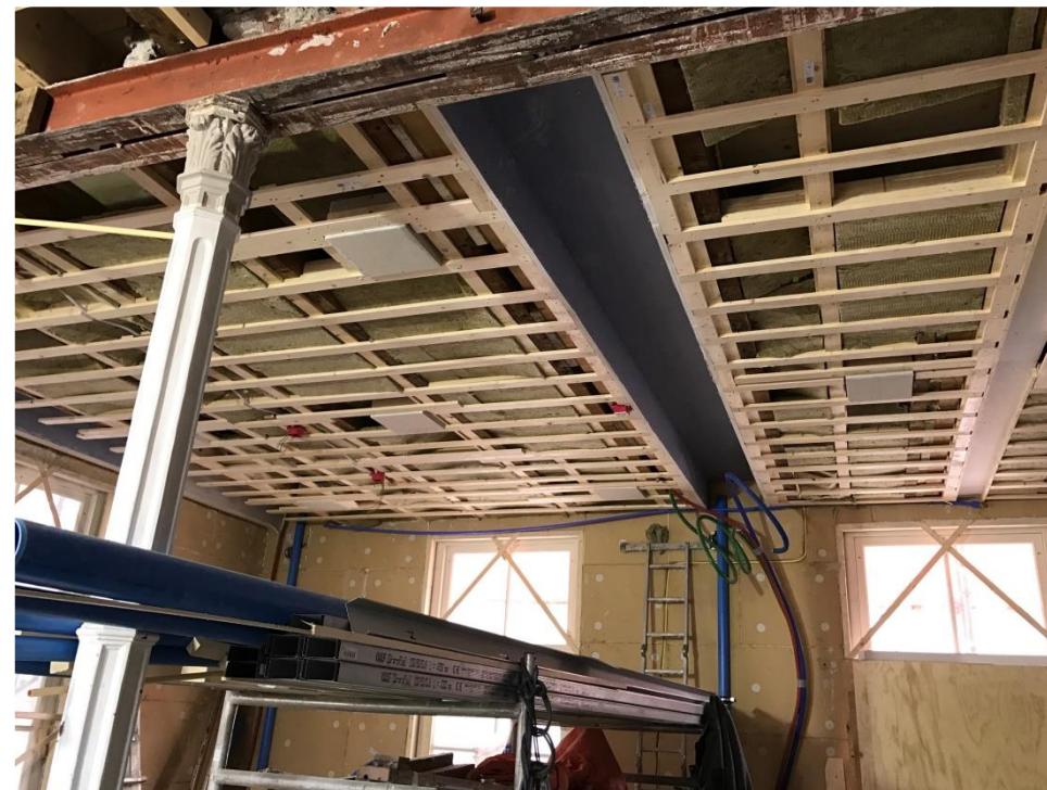
Ventilatiekanalen tussen de balken
