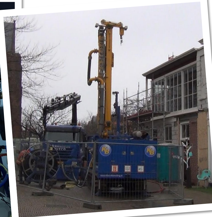
Grondbron 140 meter diep
