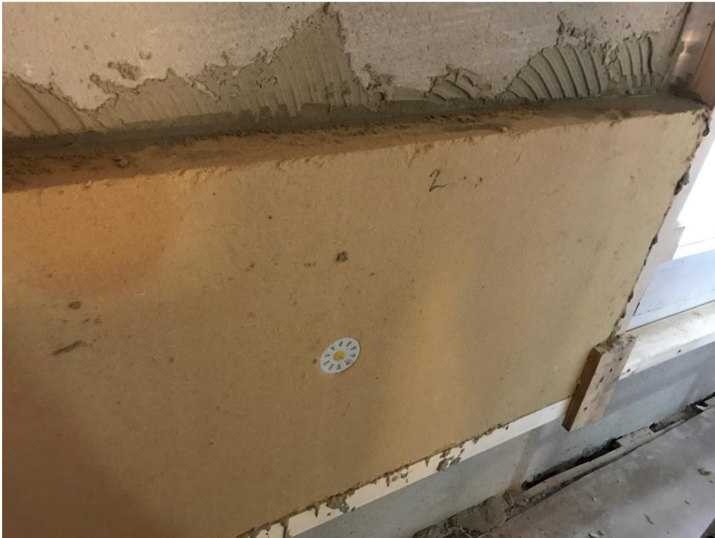
8 cm dikke houtvezelpanelen aangebracht (isolering en vochtregulering)
